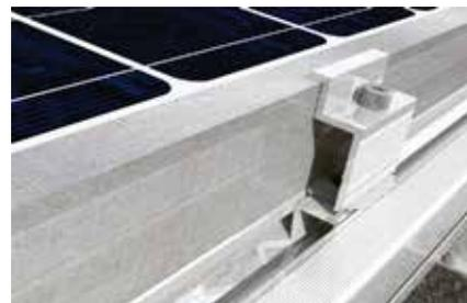
Dettaglio: fissaggio del modulo fotovoltaico
