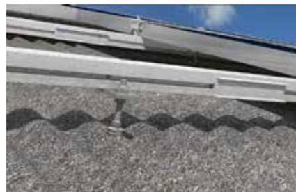
Dettaglio: vite STSI con staffa SSP
