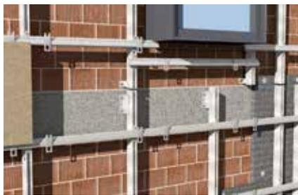
Sottostruttura montanti e traversi
