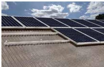
Tetto a falda con lamiera ondulata
