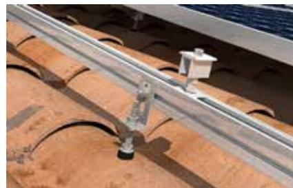
Dettaglio: vite STSR con staffa MW SA
