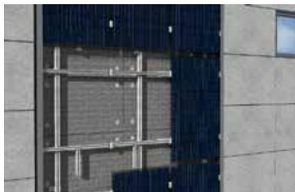
Sottostruttura montanti e traversi
