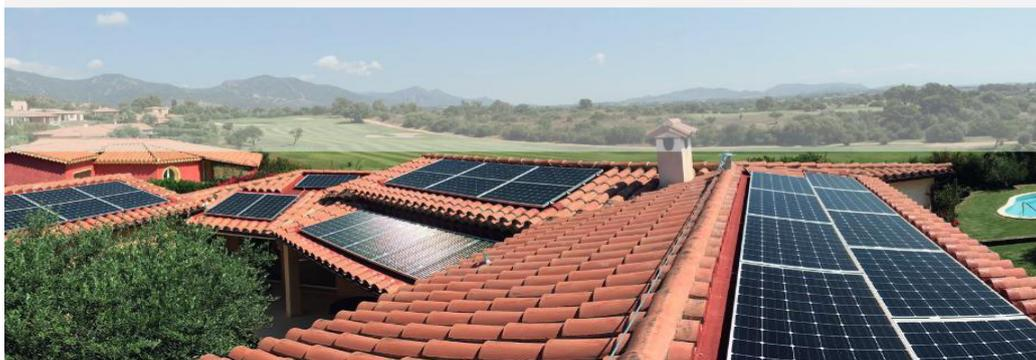
I moduli aleo S19 HE-Tec 300-310 Wp con celle CELCO tecnologia PERC, vantano un'efficienza del 21% sopra la media ed un ottimo comportamento in caso di luce diffusa. Ovvero massima produzione a livello di stringa in caso di esposizioni non ideali e di ombre all'orizzonte.
