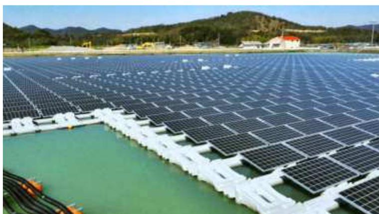
Il sistema ha più di un vantaggio: è in grado di ridurre l'evaporazione dell'acqua e la crescita delle alghe grazie all'ombreggiatura. Le piattaforme galleggianti, inoltre sono completamente riciclabili, resistenti alla corrosione e progettate per resistere a qualsiasi stress fisico, tifoni compresi.
