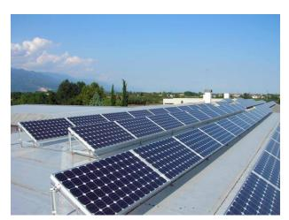
elettrica. All'interno dei moduli, infatti, la luce solare viene trasformata in energia elettrica. La corrente continua prodotta viene trasformata in corrente alternata da un alternatore per poter essere immessa nella rete pubblica oppure resta in casa per l'utilizzo diretto.
